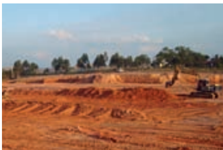
造成中の工場敷地
